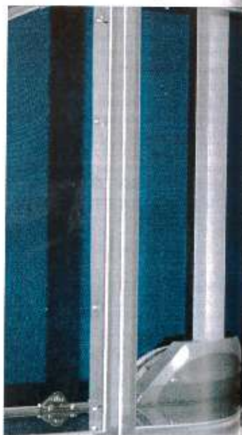
Bild 3: Wärmerohr in RLT-Gerät
